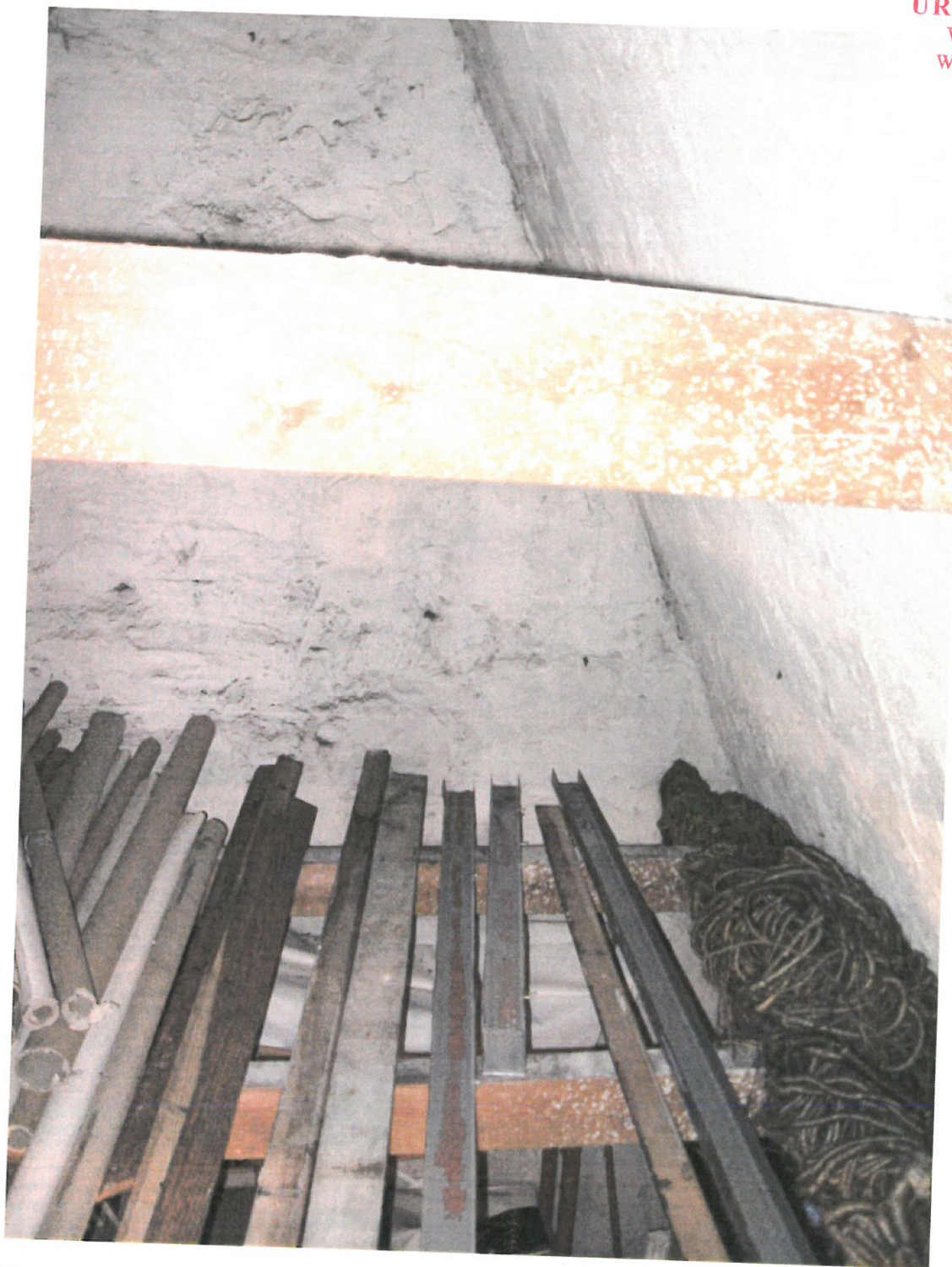
Fot. 3 Widoczne dolne jętki o przekroju 16/8 cm występujące w każdym wiązarze oraz jętki górne o przekroju 12/2,5 cm występujące w co drugim wiązarze.
