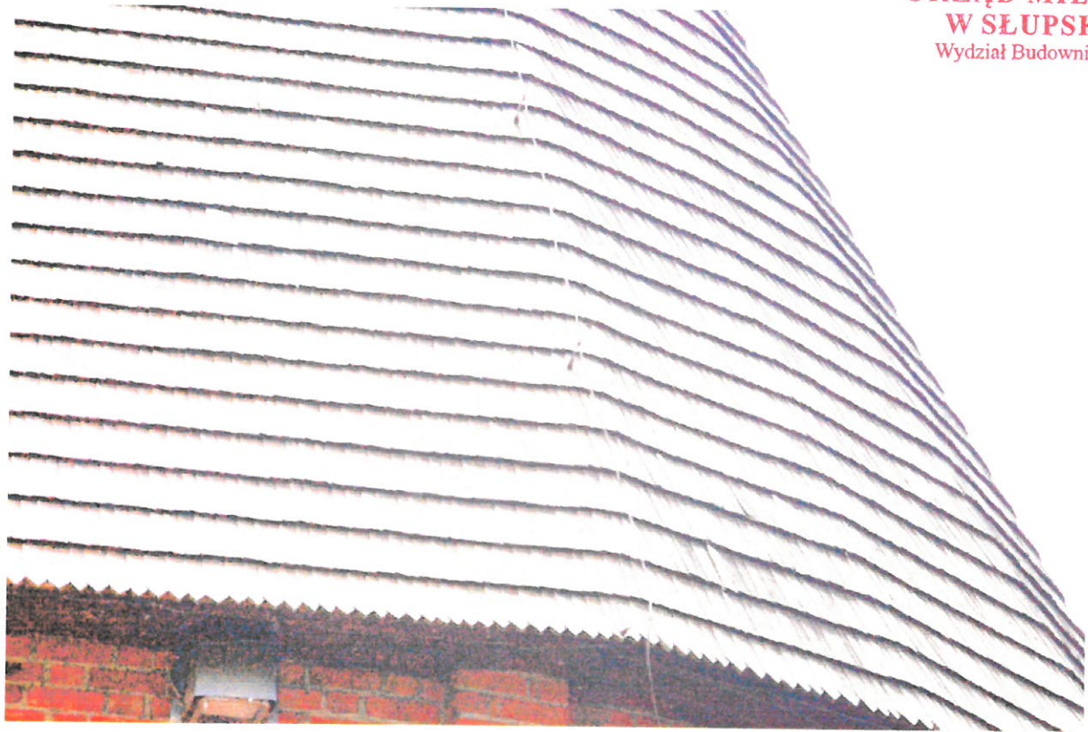
Fot. 10 Połąć dachowa południowa z widocznymi wymienianymi gontami.
